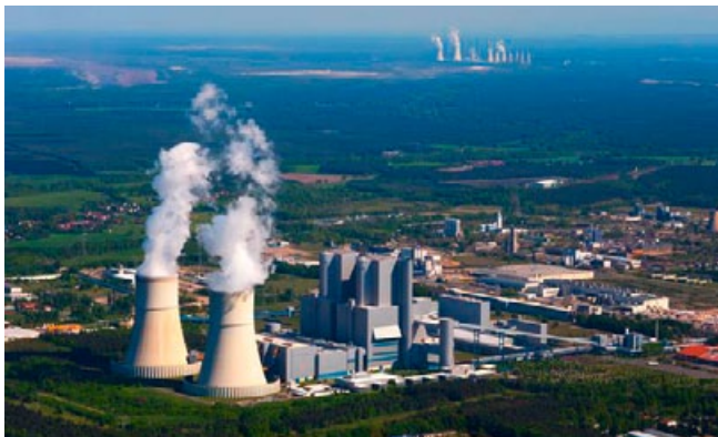
Abbildung 1: Das Kraftwerk „Schwarze Pumpe“ in der Nähe von Cottbus
